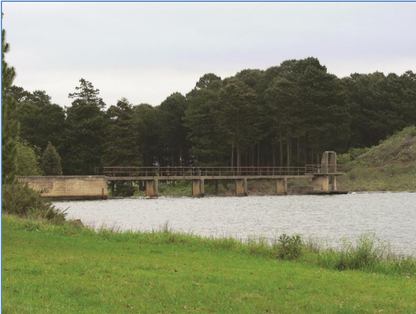
Figure 17.5 Grootgewacht Dam (DWA, 2015)
